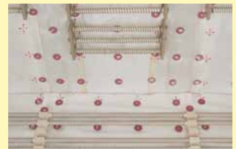
Couverture en tissu pour le tapis de fibres (et les côtés) pour réduire les poussières de fibres
