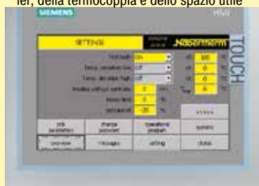
Uniformità della temperatura spazio utile es. \pm 1 K
