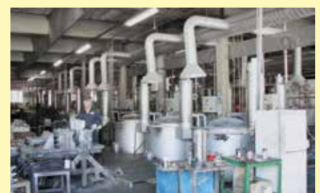
16 個の TBR 110/12 および 2 個の TBR 180/12 から成る復熱式バーナーを装備したアルミ溶解炉
