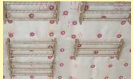
Abdeckung der Faserisolierung mit Gewebetuch zur Reduzierung der Staubbelastung im Ofen
