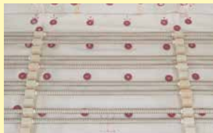
Gewebetuchabdeckung zur Reduzierung von Faserstäuben
