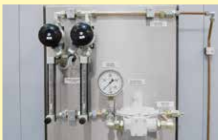
Begasungssystem für nicht brennbare Schutz- oder Reaktionsgase
