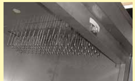
Heizregister bei elektrisch beheizter Ausführung
